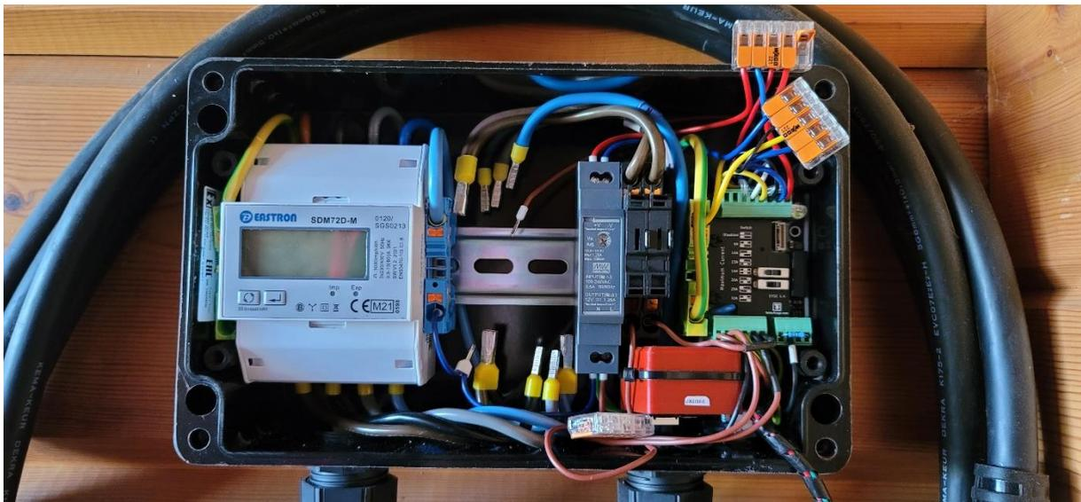
Abbildung 2 - Wallbox ohne ausgebauten Schaltschütz
